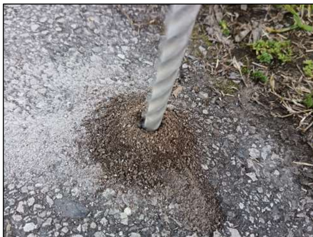
Perforazione per videoispezione e vista del foro eseguito
