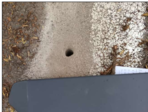
Perforazione per videoispezione e vista del foro eseguito
